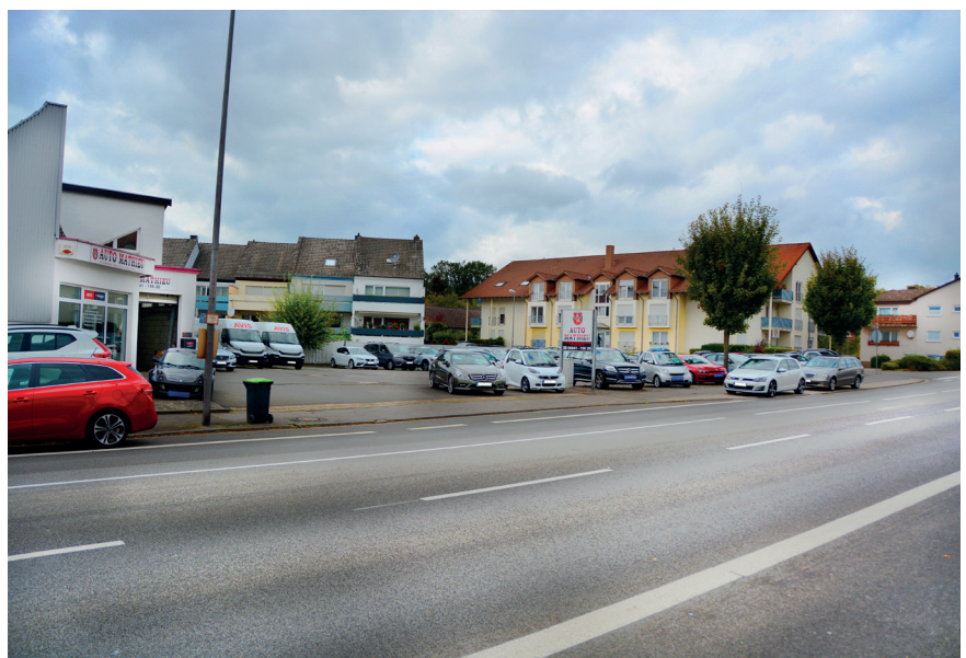
Zur Einöder Straße hin orientierte Seite des bestehenden KFZ-Dienstleisters mit unmittelbar angrenzender Werkstatt/ Büro, sowie Mehrfamilienwohnen im Hintergrund.
