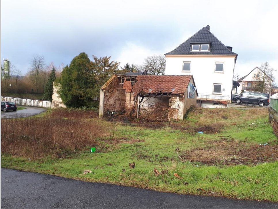
Grundstück mit Scheune und Nachbarbebauung Nordwest:
