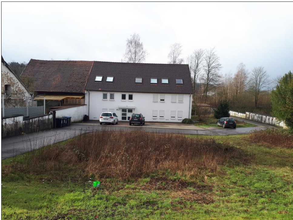
Grundstück von der Straße aus und Nachbarbebauung Süd :
