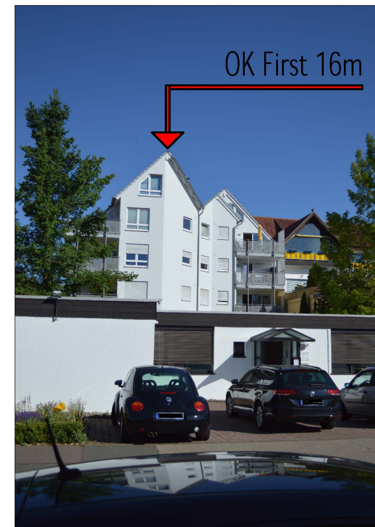
Schillerstraße 3 / Gartenseite Lessingstraße
