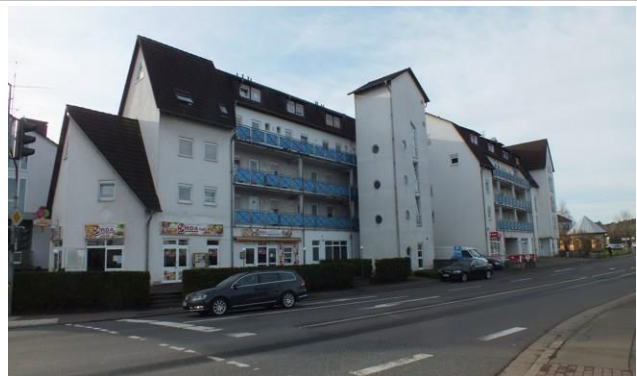
Ist-Zustand 2016, Blick von Nordosten (Fotos: isoplan)
