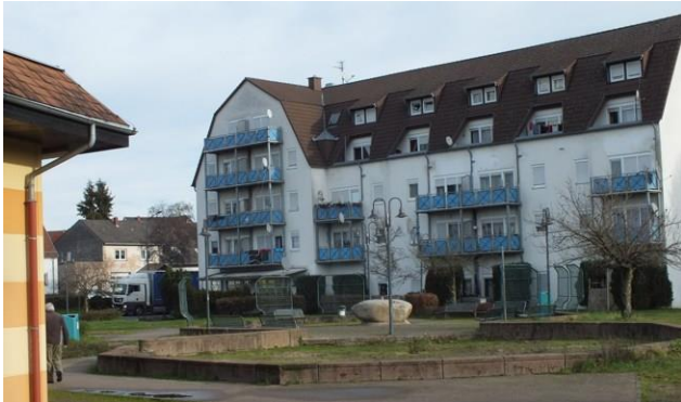
Ist-Zustand 2016, Blick vom Eduard-Vollmar-Platz
