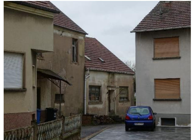
Abbildung 9: Städtebauliche Missstände im Ortskern Erbach – Sanierungsstau, uneinheitliches Erscheinungsbild, ungestaltete Straßenräume
