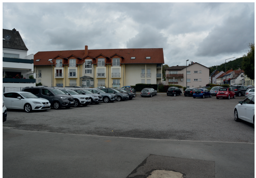
Stellfläche KFZ-Betrieb, sowie Mehrfamilienwohnen im Hintergrund.
