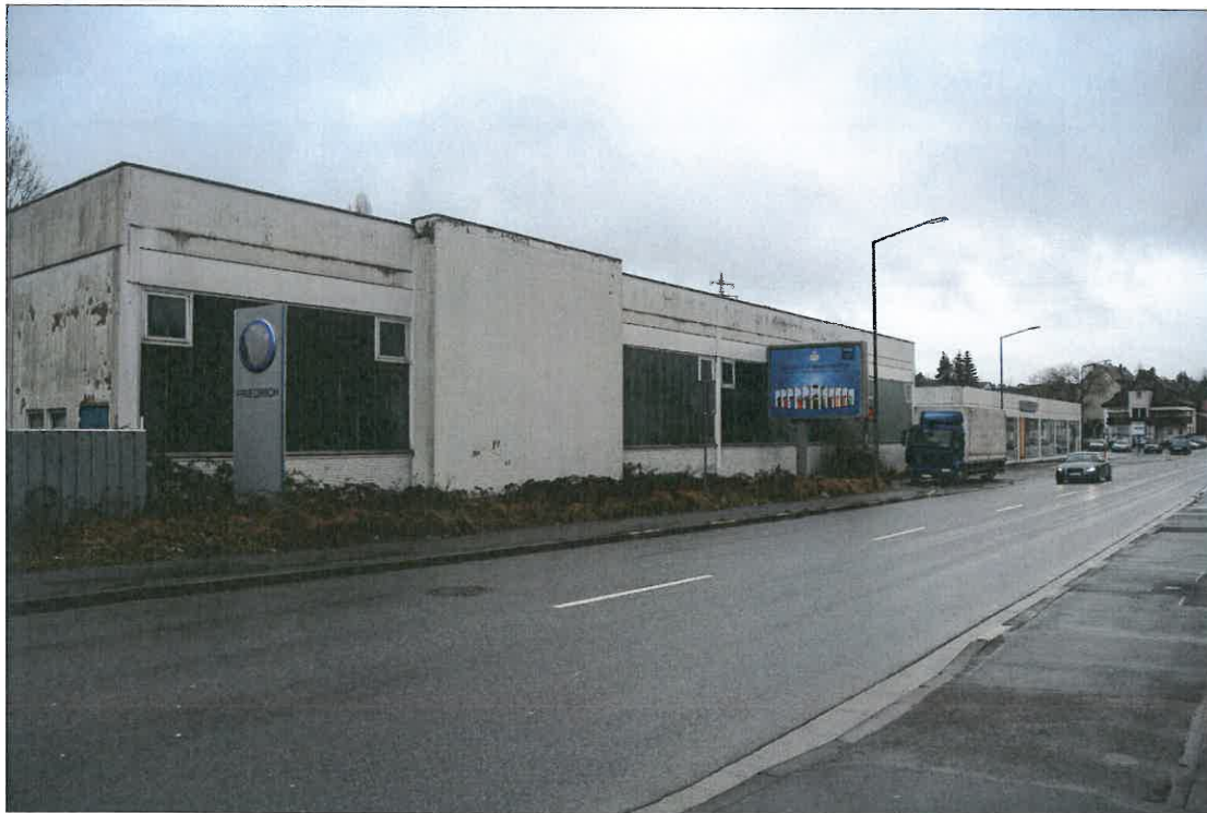
Blick auf das Plangebiet aus Richtung Westen; Quelle Foto: Kernplan GmbH, Stand: 02.02.2021
