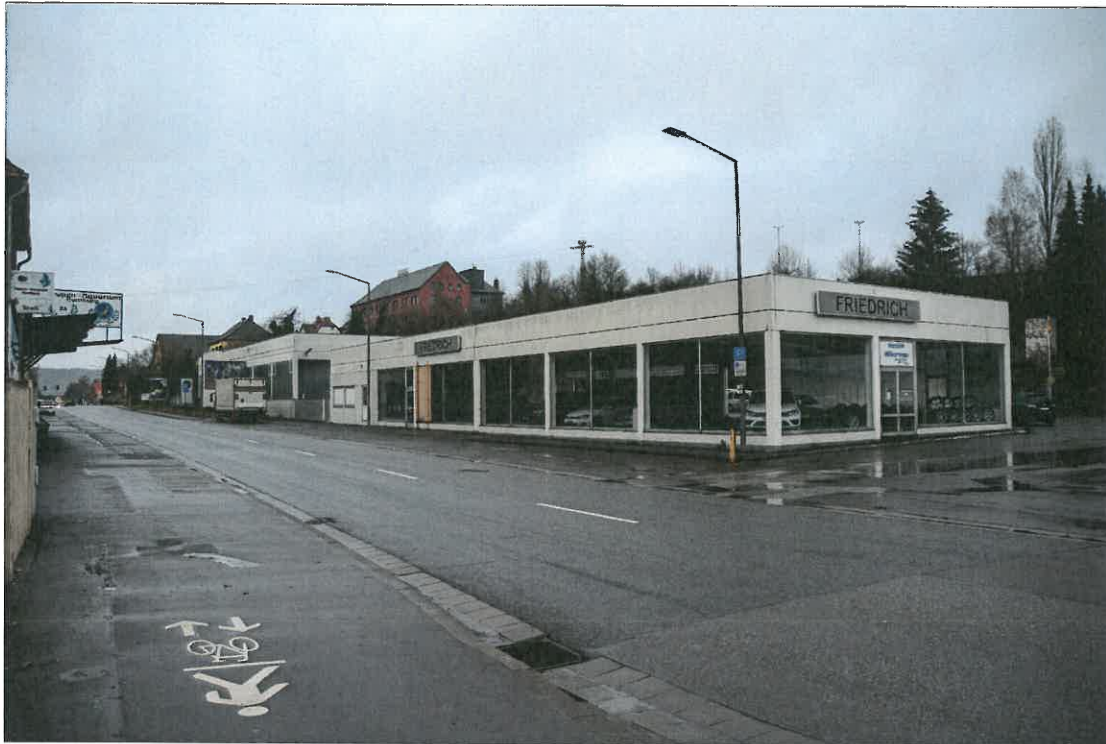
Blick auf das Plangebiet aus Richtung Süden; Quelle Foto: Kernplan GmbH, Stand: 02.02.2021
