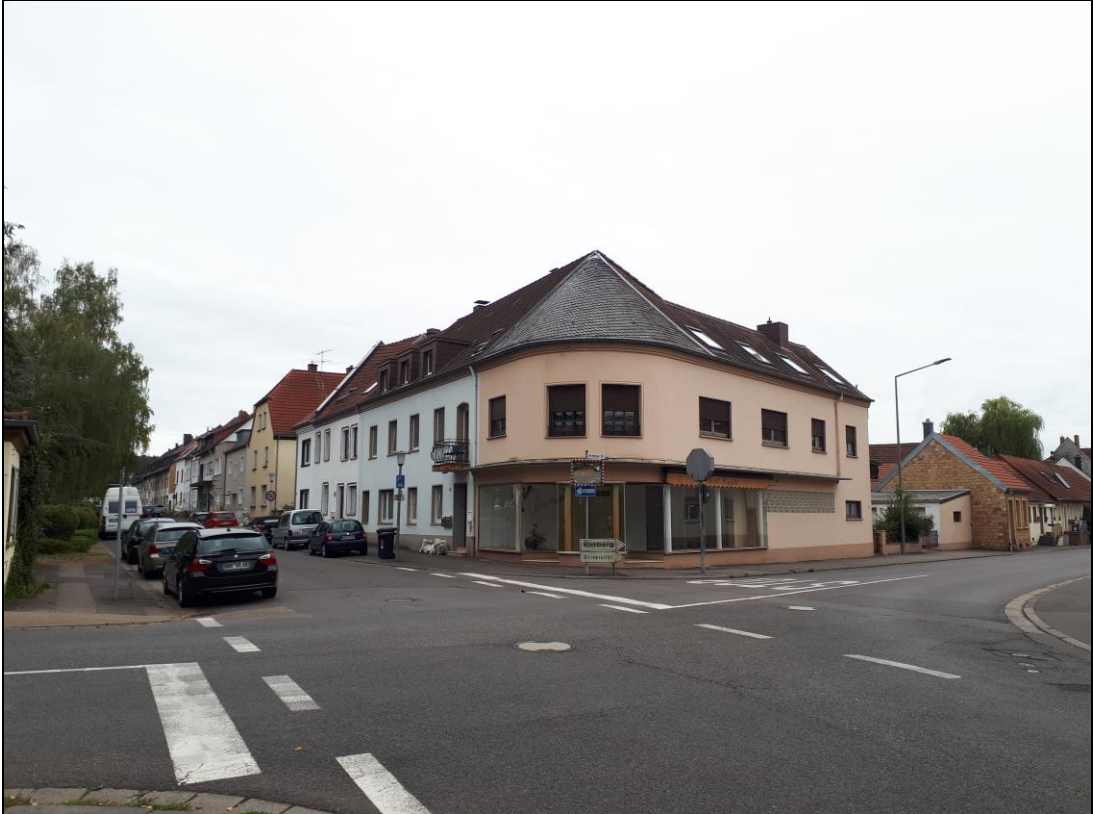
Ecke Untere Allee Nr. 30 / Kirrberger Straße Nr. 2 (Blick Richtung Osten)
