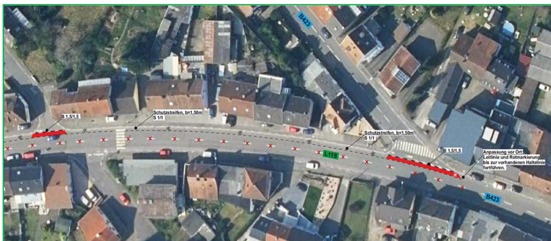
Bild 55: Radverkehrsführung im Einmündungsbereich Kleinottweilerstraße
