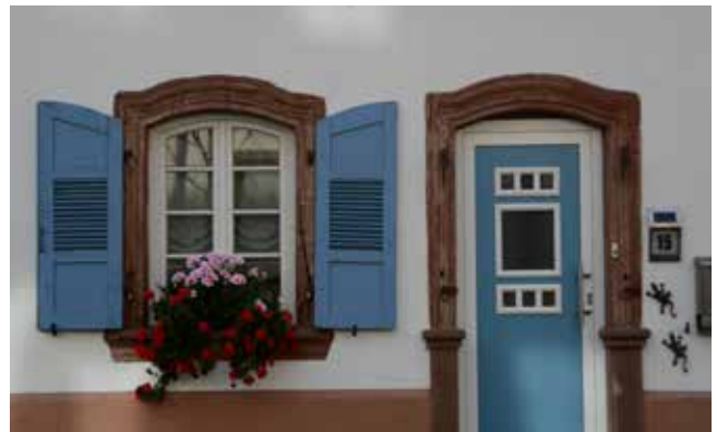
Attraktiv sanierte Fenster- und Türflächen zum Zeitpunkt der Bestandserfassung 10/2019
