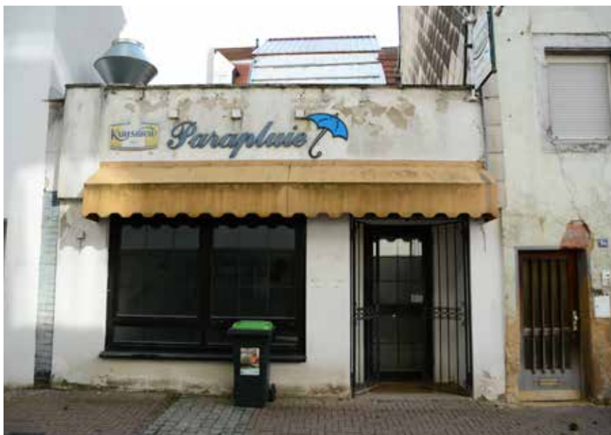
Leerstehender Gastronomiebetrieb im Bereich der Untergasse zum Zeitpunkt der Bestandserfassung 10/2019
