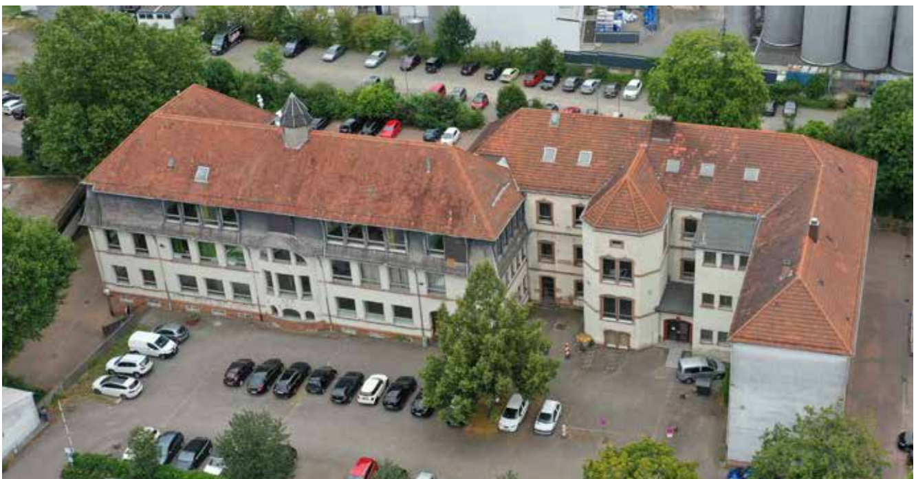
Gebäude der „Hohenburgschule“ mit Modernisierungs- und Instandsetzungsbedarf zum Zeitpunkt der Bestandserfassung 10/2019
