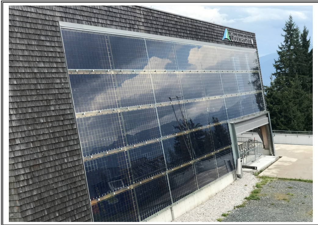
Beispiel Photovoltaik-Fassade, Glocknerbahn Zell am See
