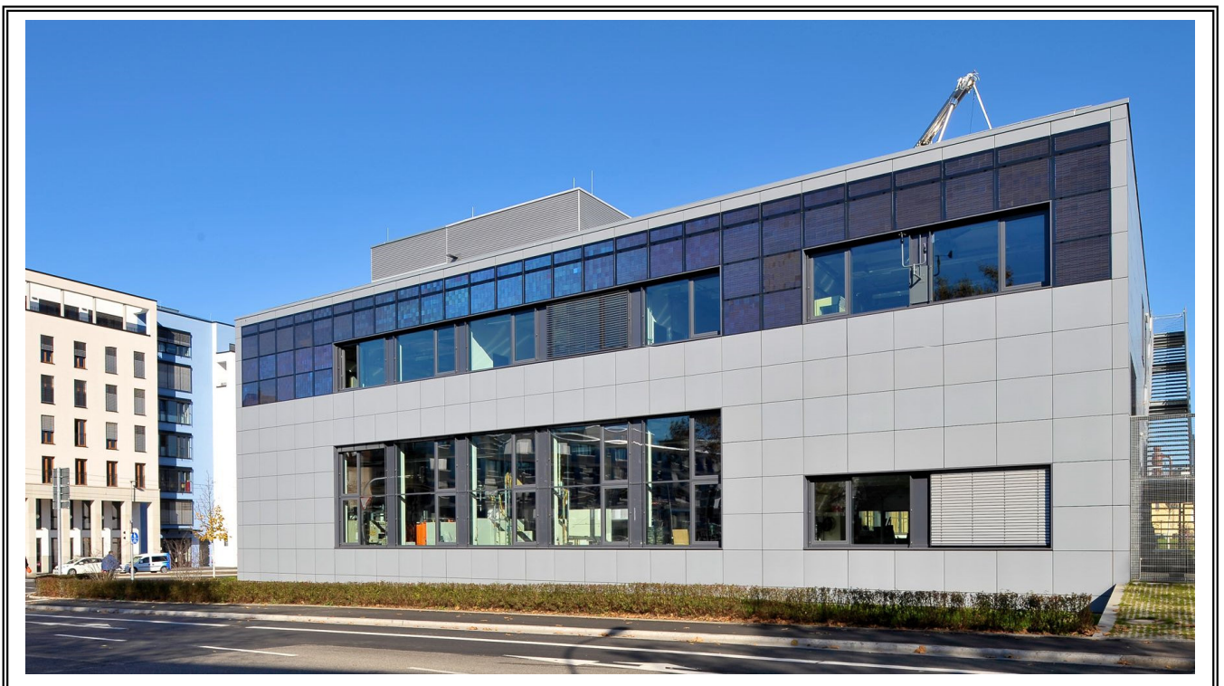
Vorhangfassade Fraunhofer ISE, Freiburg
