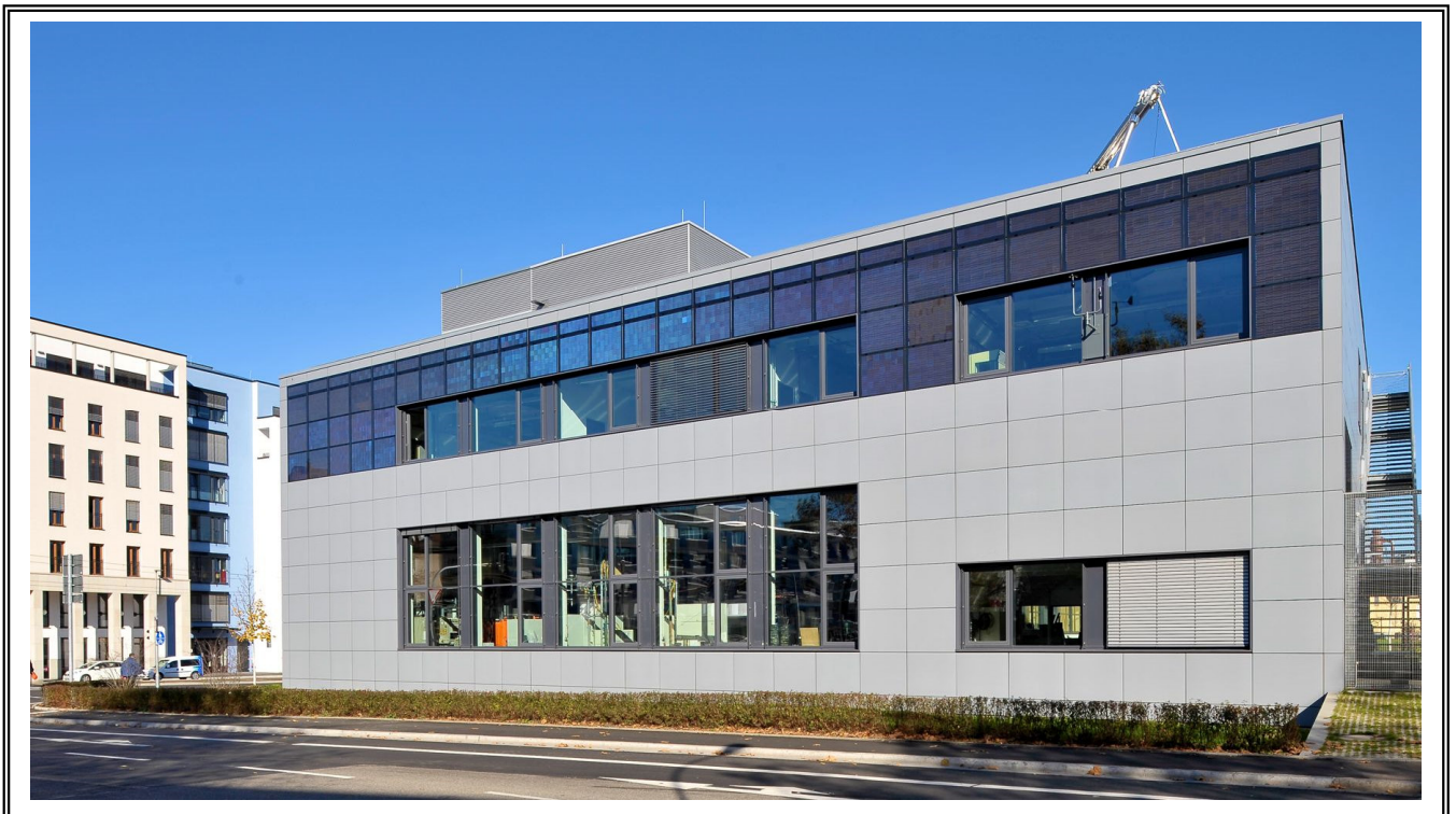
Vorhangfassade Fraunhofer ISE, Freiburg
