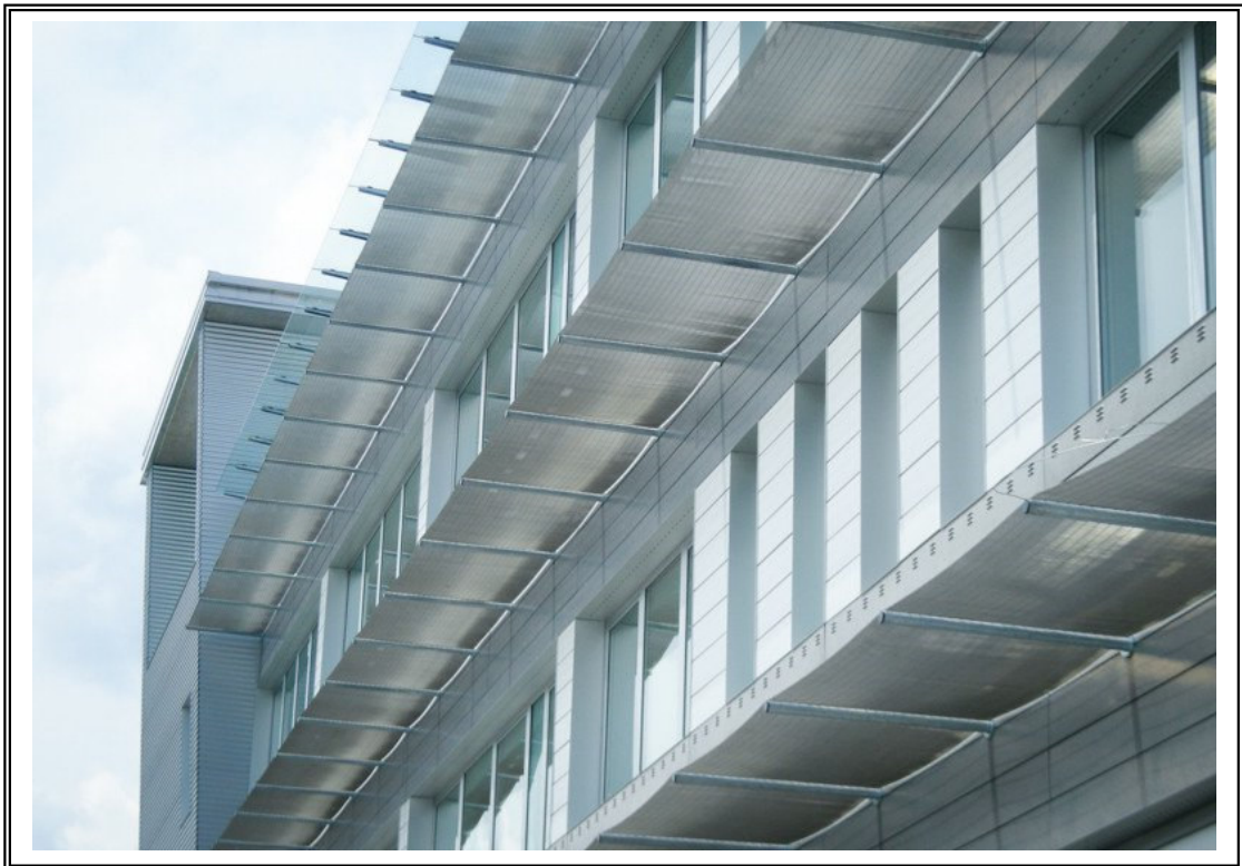
Sommerlicher Wärmeschutz durch Überdachung
