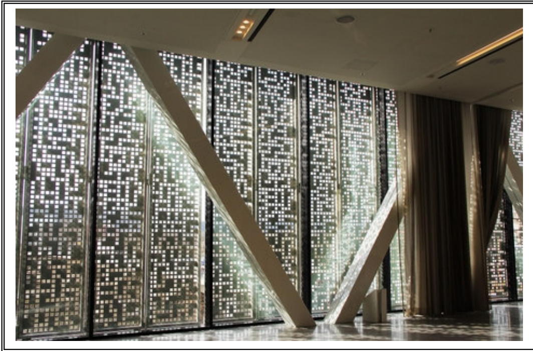
Sommerlicher Wärmeschutz aus Lochblech
