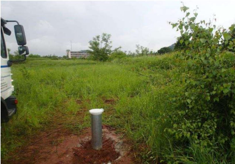
Grundwassermessstelle S0572 mit Stahlschutzrohr und SEBA-Sicherheitsverschlusskappe
