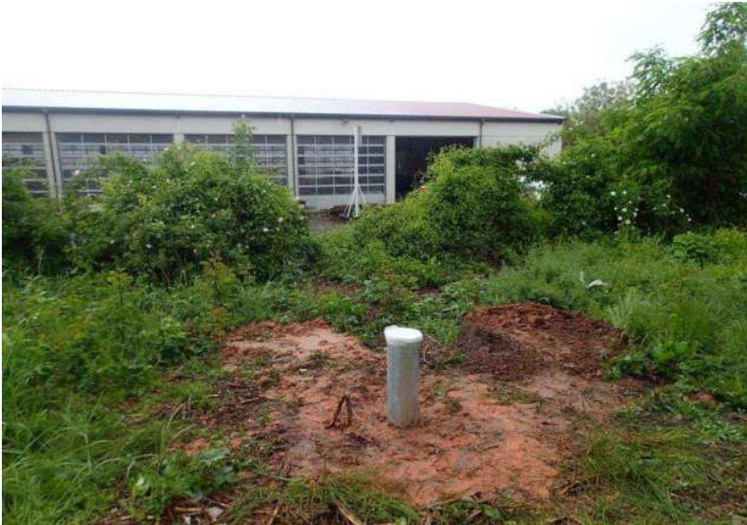
Grundwassermessstelle S0571 mit Stahlschutzrohr und SEBA-Sicherheitsverschlusskappe
