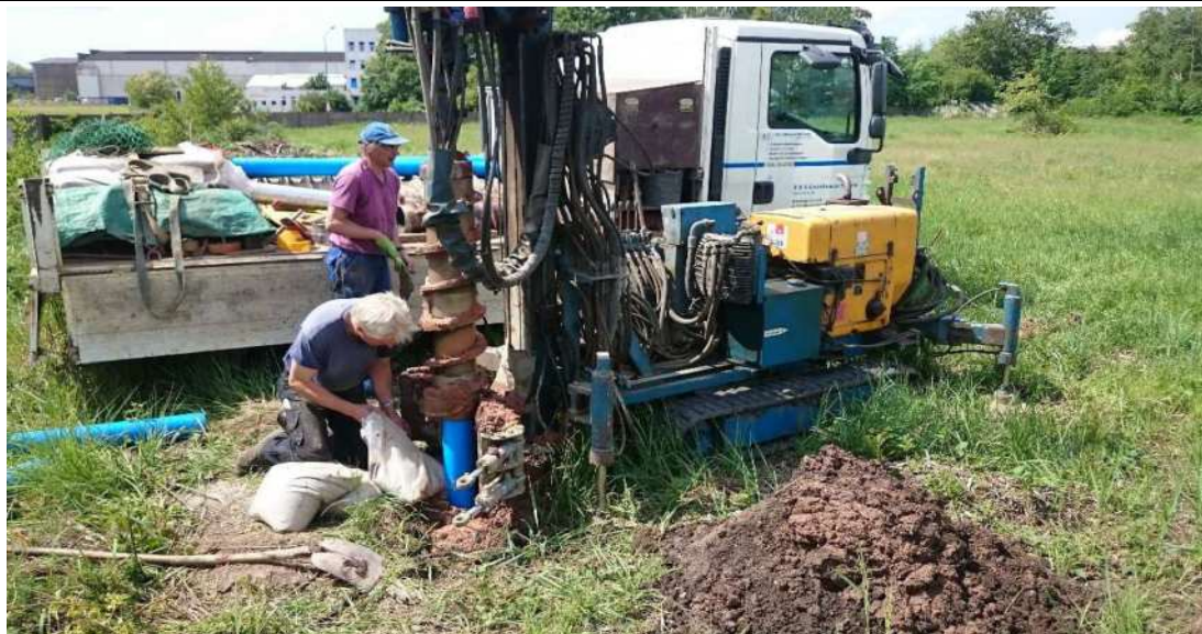
Verfüllung des Ringraums mit Quarzkies (Körnung 1,00 - 2,00 mm)
