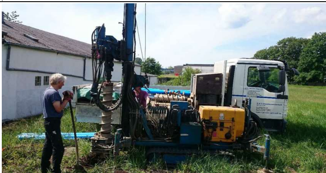
Schneckenbohrverfahren
