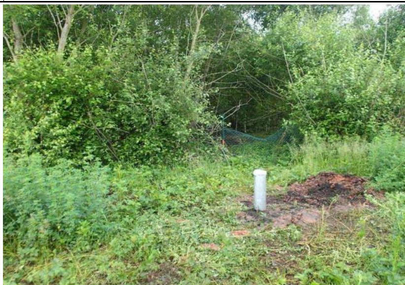
Grundwassermessstelle S0569 mit Stahlschutzrohr und SEBA-Sicherheitsverschlusskappe
