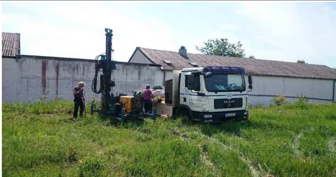
Bohrgerät zur Errichtung der Grundwassermessstellen S0569, S0570, S0571, S0572 und S0573
