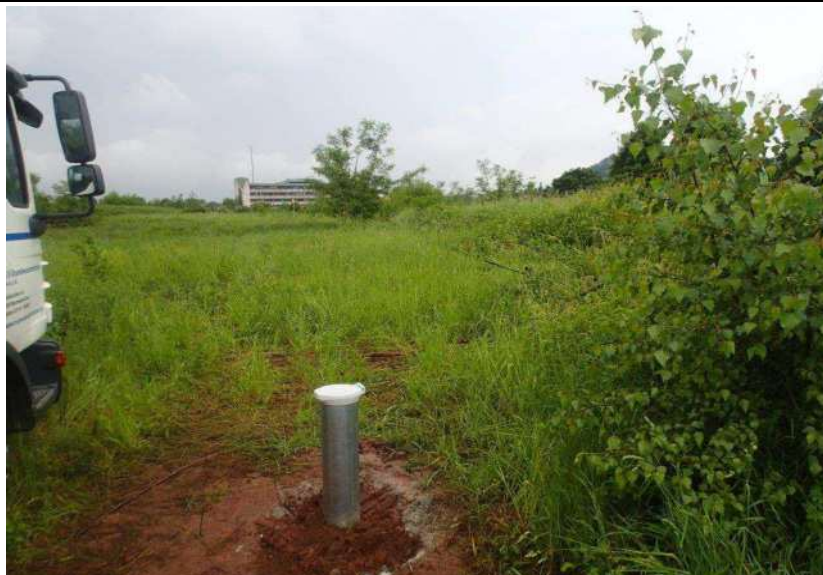
Grundwassermessstelle S0572 mit Stahlschutzrohr und SEBA-Sicherheitsverschlusskappe
