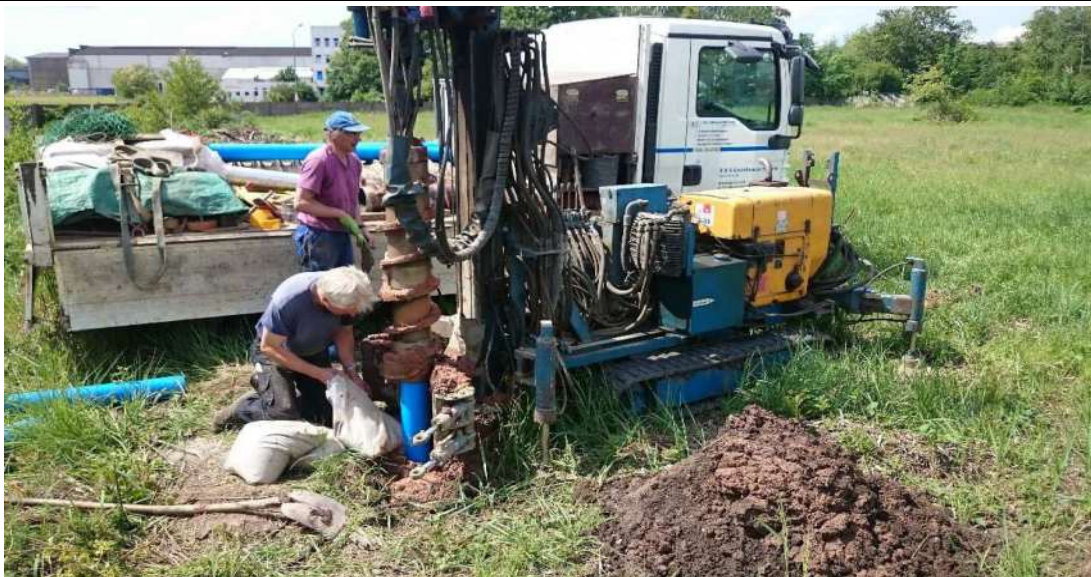
Verfüllung des Ringraums mit Quarzkies (Körnung 1,00 - 2,00 mm)
