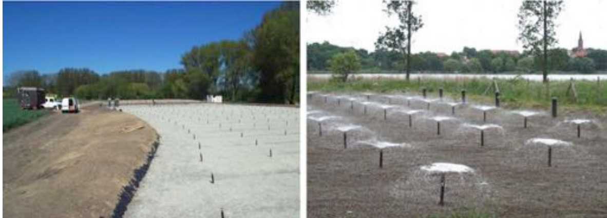
Abbildung 9.40: Phosphorelimination durch Bodenfilter – Neptun Polyplan (Bild Polyplan GmbH)
