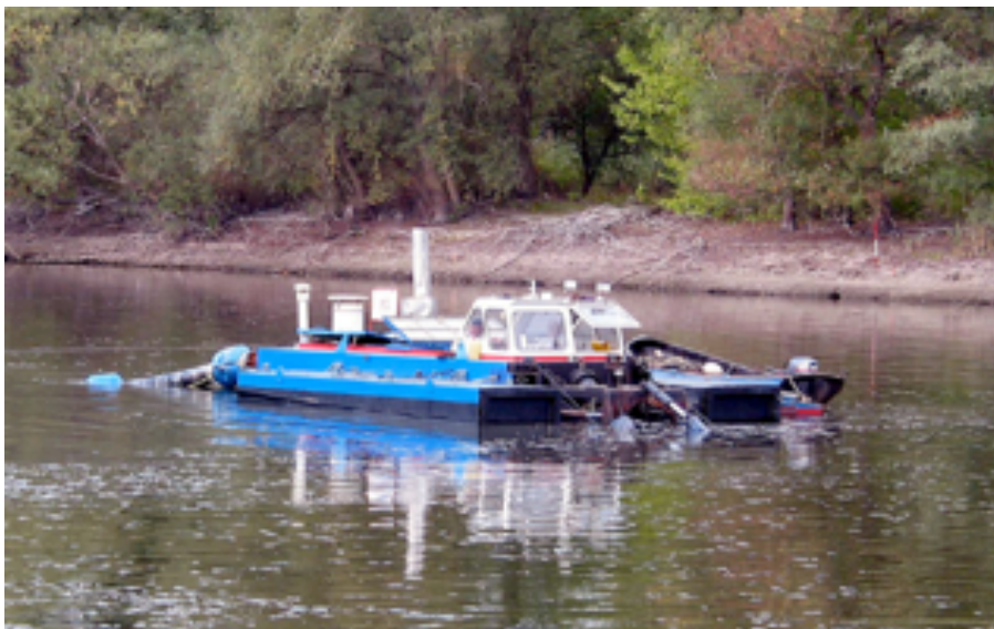
Abbildung 9.28: Beseitigung der Sedimente mittels Saugbagger
