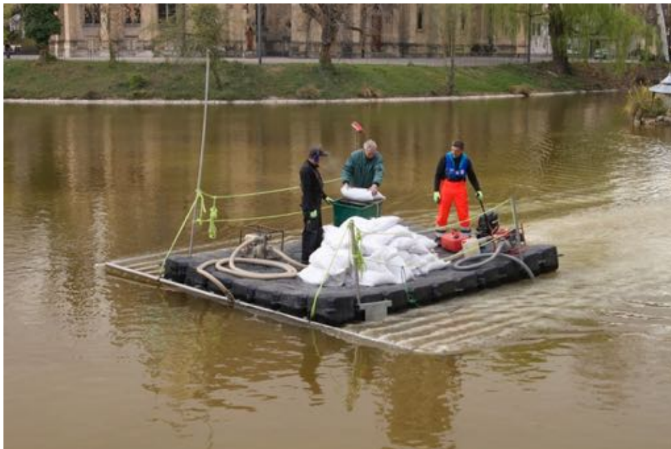
Abbildung 9.23: Bentophosapplikation im Feuersee in Stuttgart (Foto BGL)
