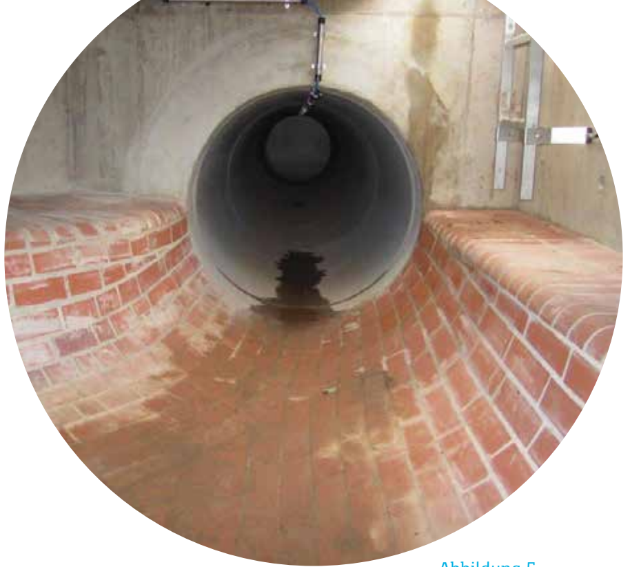
Abbildung 5 Regenüberlaufbecken in der Abwasseranlage Niedersaubach, Lebach
