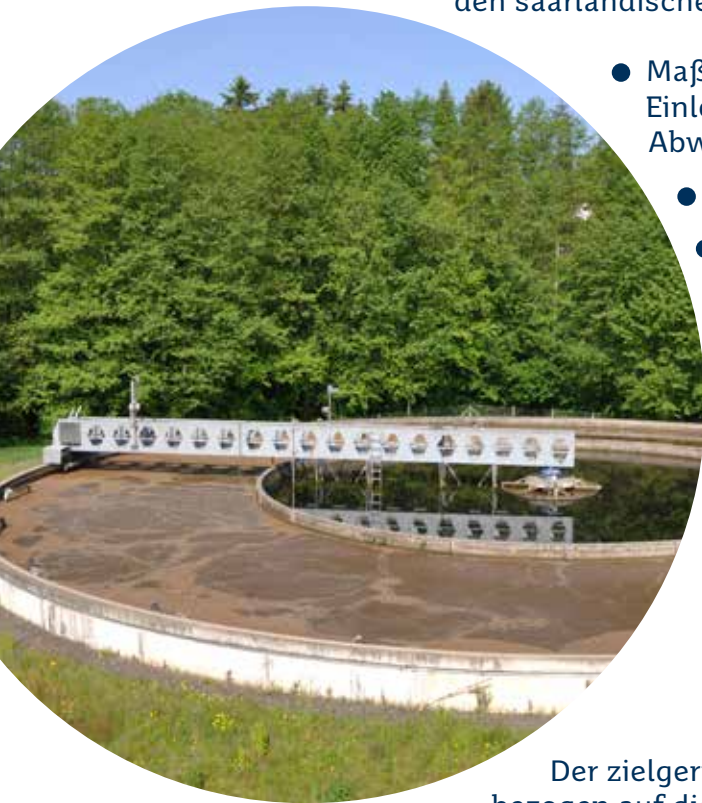
Abbildung 2 Kläranlage Bubach- Calmesweiler
