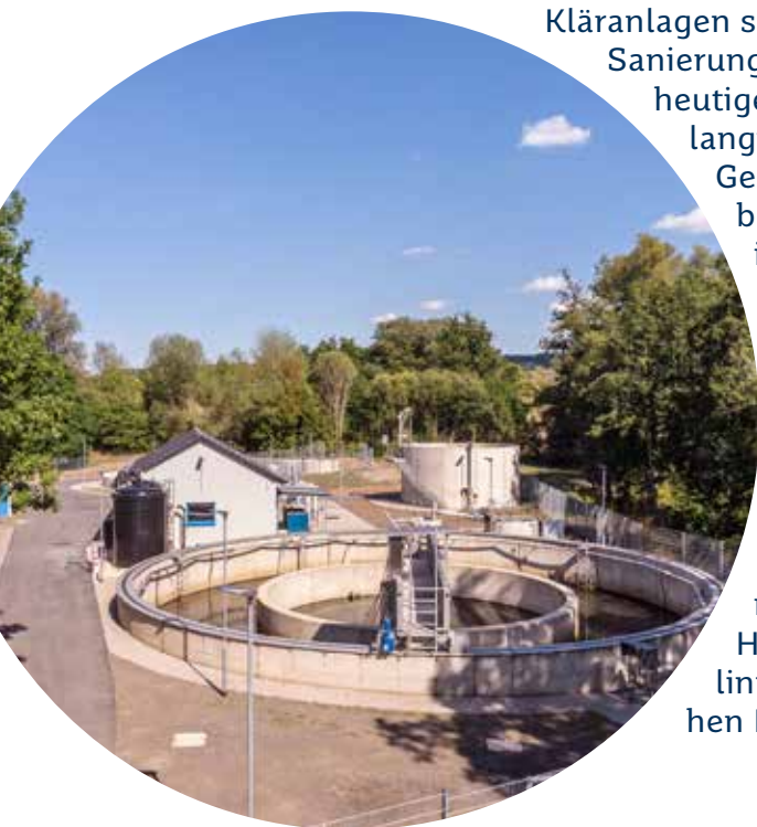
Abbildung 12: Kläranlage Erfweiler- Ehingen
