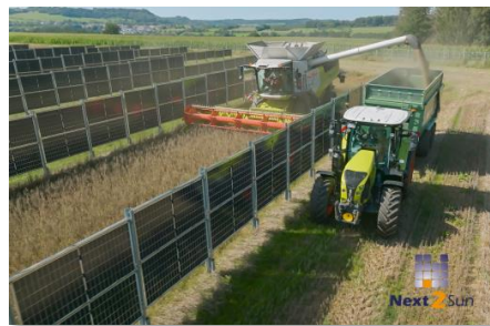
Agri-PV Park Wellingen (Saarland) mit 4,1 MWp
