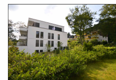
HsNr. 15a, Ansicht aus Baugrundstück
