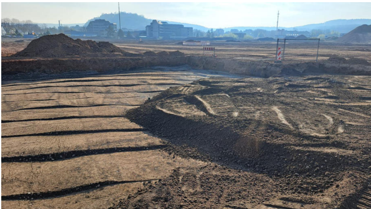
Bild 6: Lagenweiser Einbau und Verdichtung der Schottertragschicht (Foto: M. Beckert, Aufnahmedatum: unbekannt).
