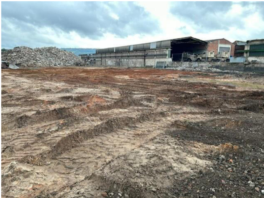
Bild 1: Übersichtsfoto über das Flurstück 1888/11 nach dem erfolgten Rückbau des Bestandsgebäudes (Foto: A. Kramatschek; Aufnahmedatum: unbekannt).
