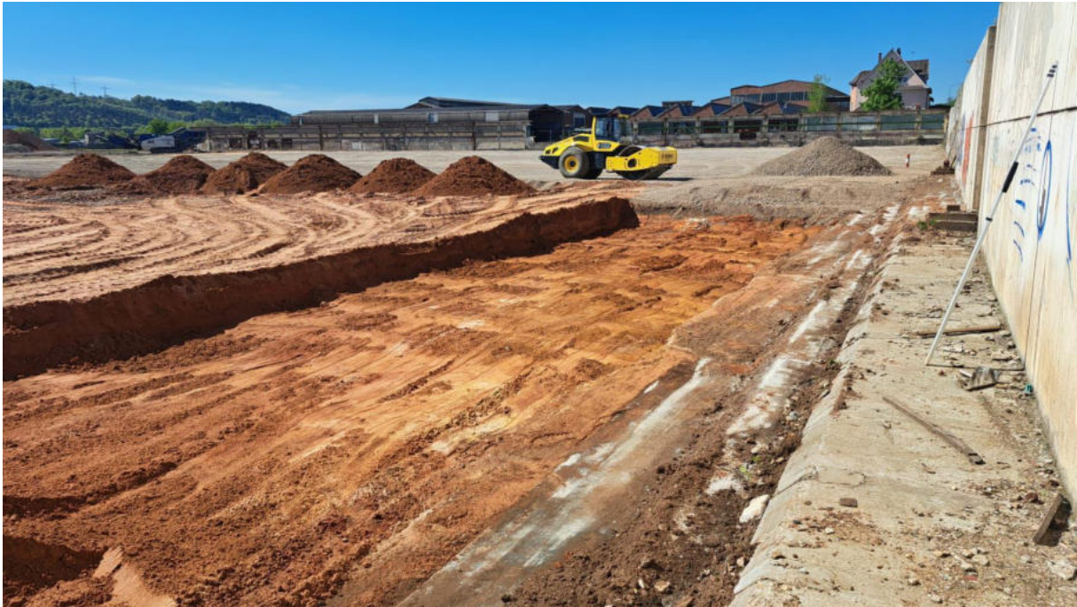
Bild 7: Verdichtung der Schottertragschicht (Foto: M. Beckert, Aufnahmedatum: unbekannt).
