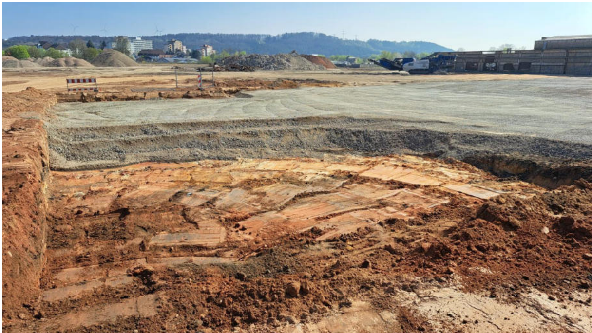
Bild 3: Herstellung der Schottertragschicht (Foto: M. Beckert, Aufnahmedatum: unbekannt).
