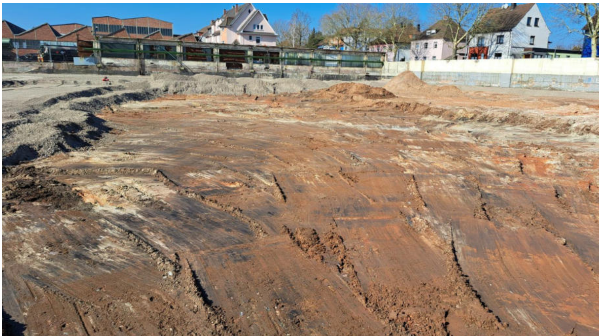
Bild 4: Herstellung der Schottertragschicht (Foto: M. Beckert, Aufnahmedatum: unbekannt).
